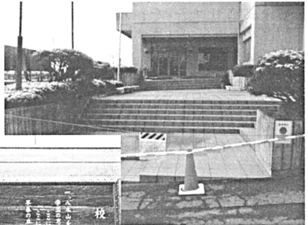
本館入口付近 2011.3.12
